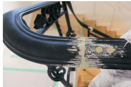
継目の隙間やネジ頭をポリパテ仕上げした後、本体と同色でタッチアップ塗装して完了。
